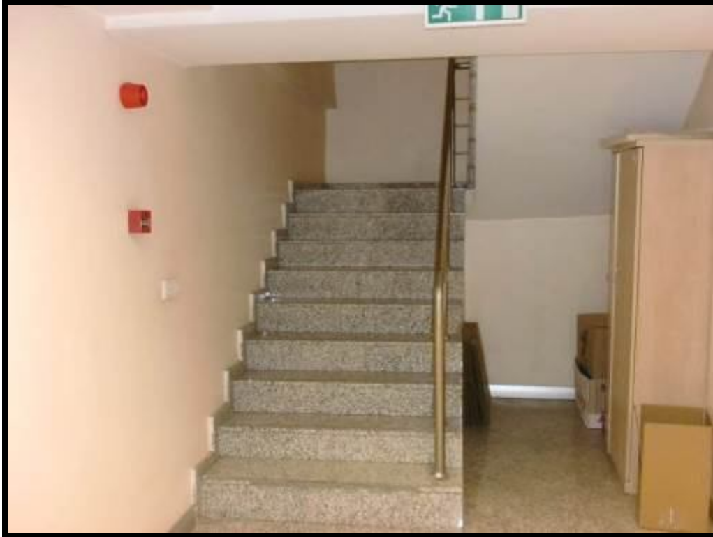
Bodrum Kattan Görünüm
