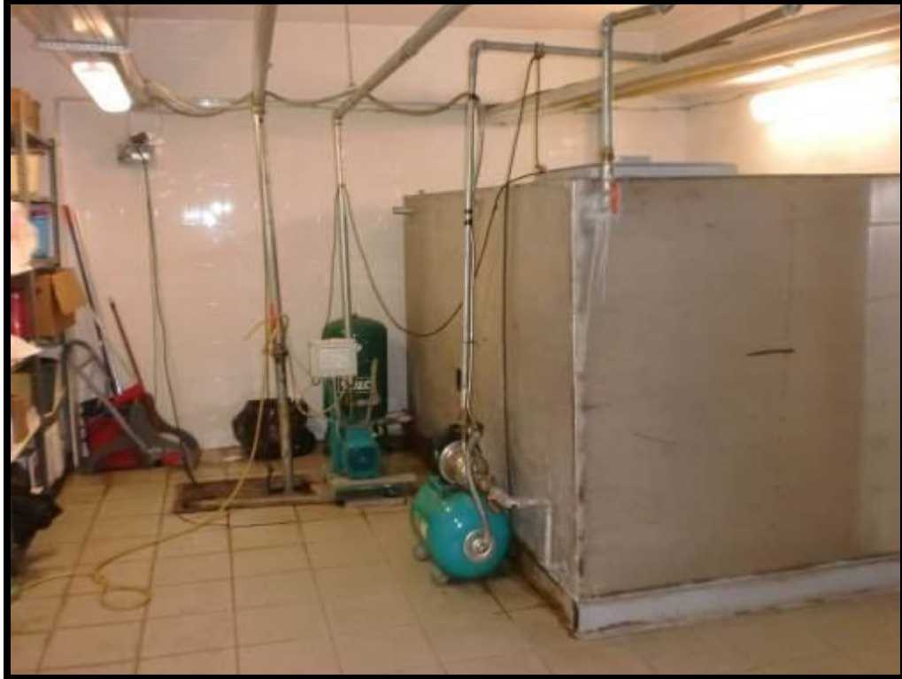
Bodrum Kattan Görünüm
