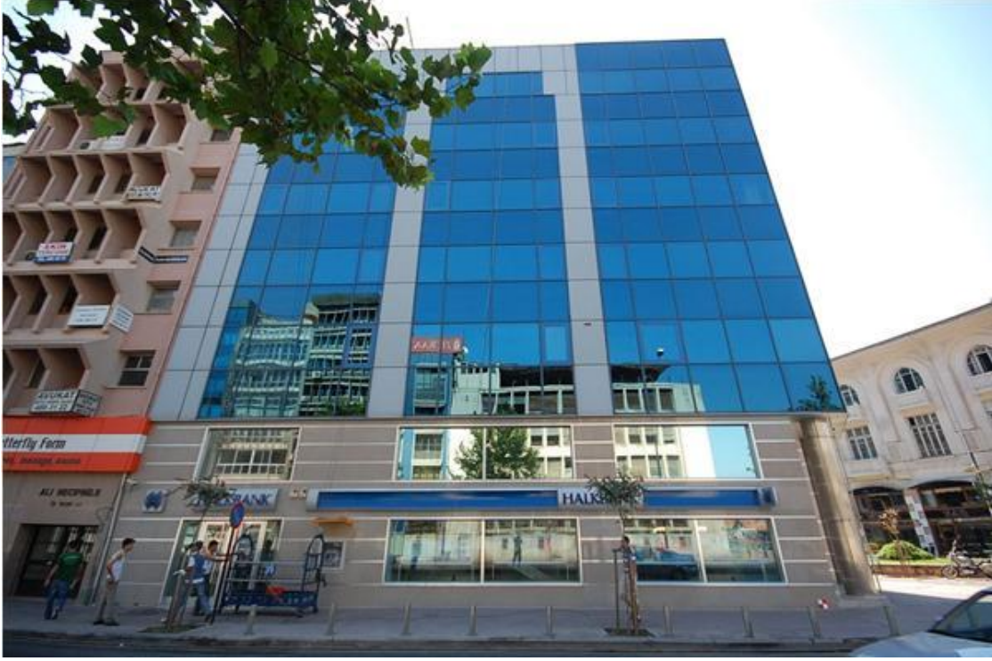
Cumhuriyet Bulvarı Cephesi (2.Kordon)
